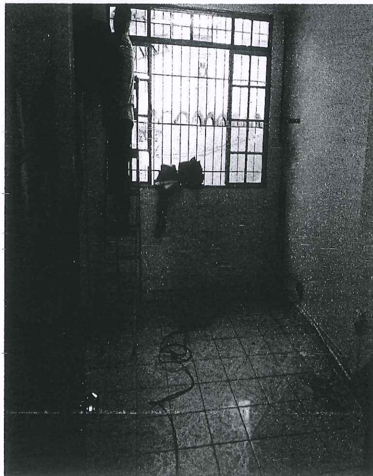
Sala antes da pintura
